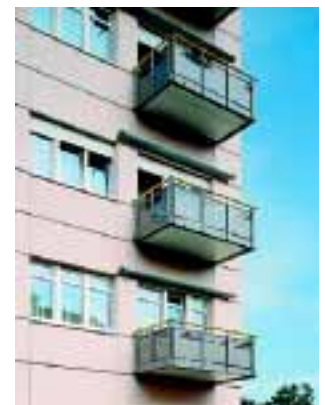
Freitragende Lösung, die kein Fundament und keine Stützen benötigt.
