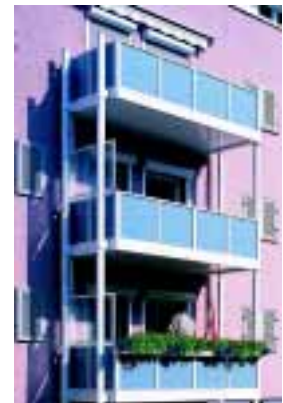
4 Stützen an allen Balkonecken. Baukörperanschluss mit Gleitanker.
