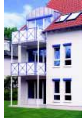
2 Stützen an der Frontseite des Balkons. Anbindung an die Fassade durch starre Wandanker.
